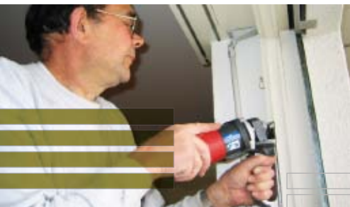
FRÄSARBEITEN OHNE VIEL STAUB UND SCHMUTZ DANK INTEGRIERTER STAUBABSAUGUNG.
